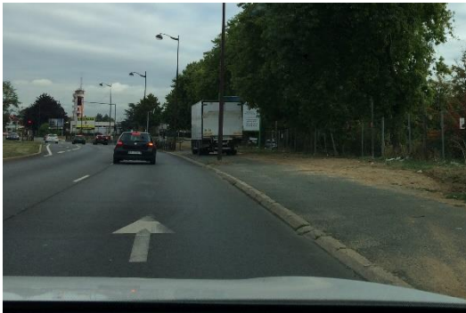
1 – Trottoir dégradé et encombré le long de la RD445
