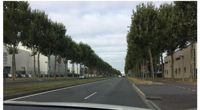
2 – Fortes emprises des voiries sur la RD310
