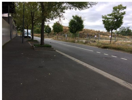
8 – Espace confortable attribué aux piétons sur la promenade du Canal
